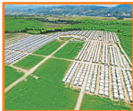
大愛村整建工程
